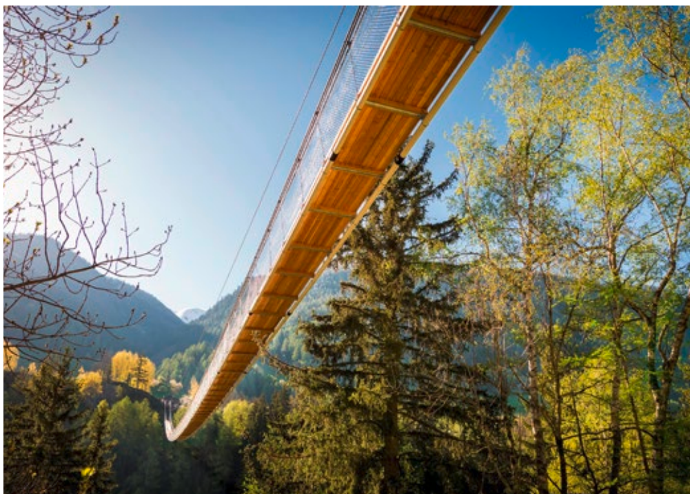
Hängebrücke zwischen Fürgangen und Mühlebach | Bild: Brigitte Wolf
